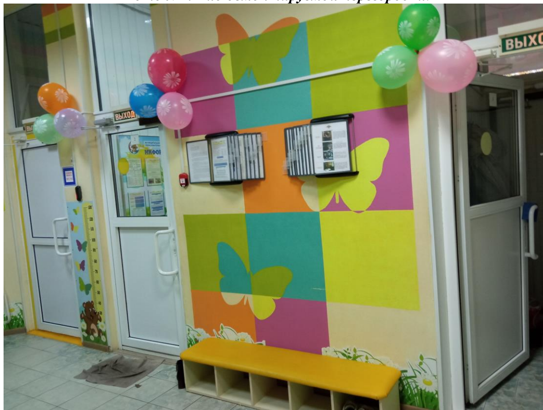
Фото №2. Вид демонтируемой перегородки.
