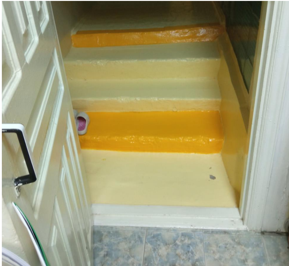
Фото №3. Вид дверного проема и лестничного марша.
